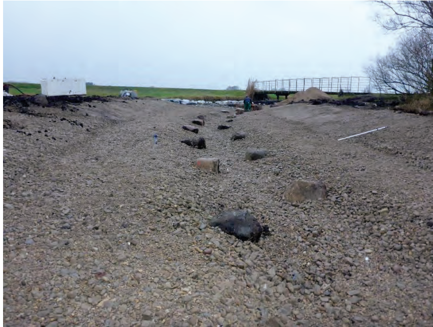
Sohle nach der Fertigstellung
