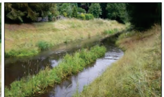
Abb. 31: Inseln und Buhnen zur Strukturverbesserung eines für den Hochwasserschutz ausgebauten Gewässers in der Stadt (Assenheim, Hessen), links Buhnen nach dem Einbau, mit Kiesüberrieselung und rechts Insel nach 1 Jahr Entwicklung und höherem Abfluss (Fotos: Frank Spundflasch)
