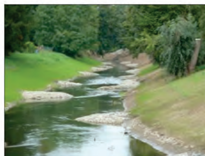
Abb. 31: Inseln und Buhnen zur Strukturverbesserung eines für den Hochwasserschutz ausgebauten Gewässers in der Stadt (Assenheim, Hessen), links Buhnen nach dem Einbau, mit Kiesüberrieselung und rechts Insel nach 1 Jahr Entwicklung und höherem Abfluss (Fotos: Frank Spundflasch)
