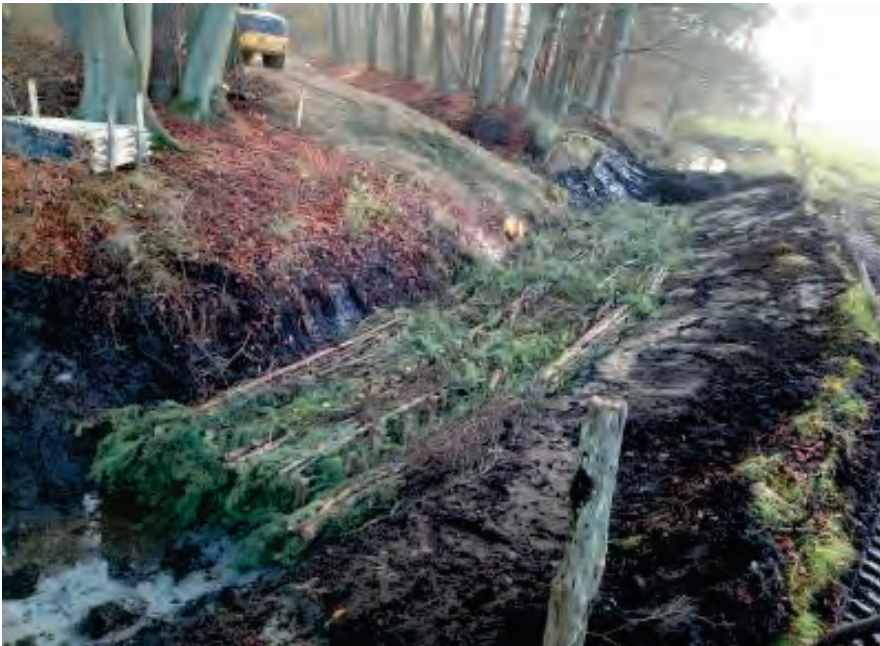
Aufstau und Sohlenanhebung von tiefen Moorgräben durch Staubauwerke aus natürlichen Baustoffen (Faschinenpackwerke als Filter), Landgesellschaft – MV Foto: Nicole Spundflasch
